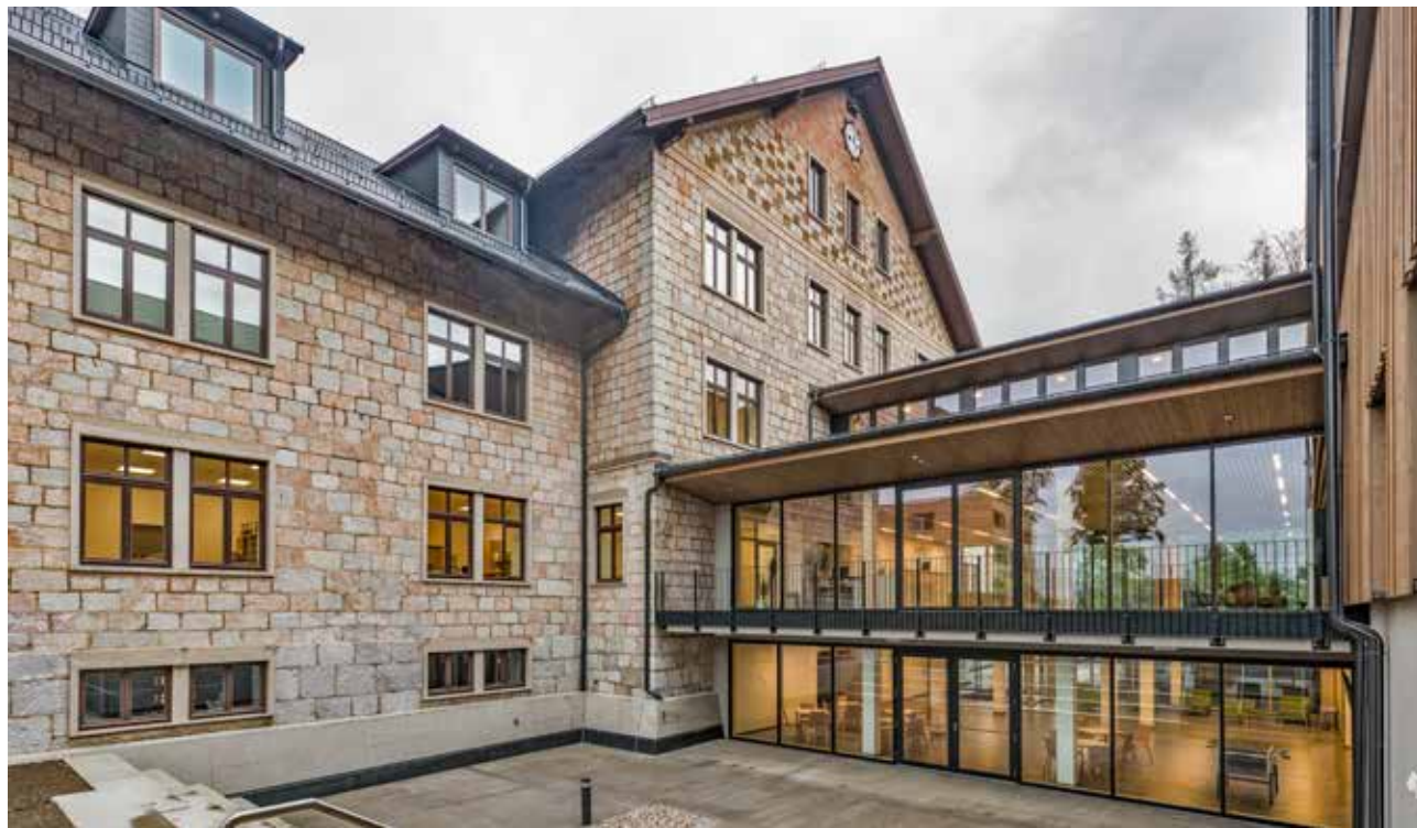
Das FBZ verbindet – sichtbar – das Alte mit dem Neuen.
