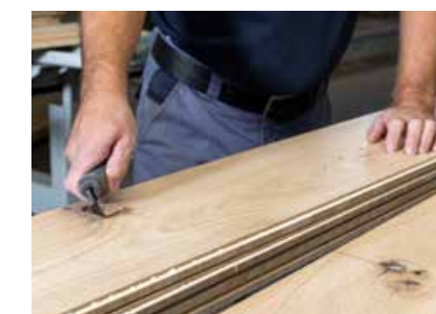
Auskratzen von losen Fasern vor dem Kitten.
